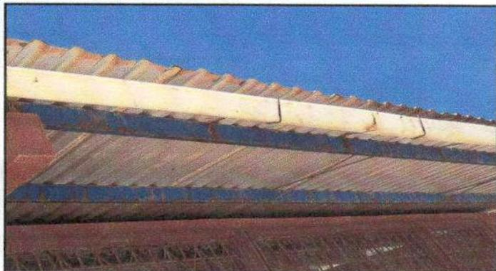
Foto 3: 7, canales y bajadas de agua pluviales: 7,2 sustituciones de canal PVC
